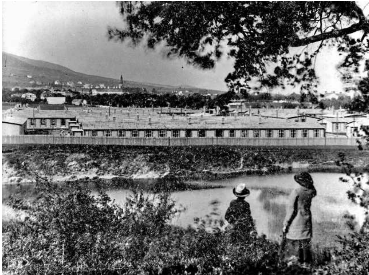
Barackenlager in der Vöslauer Straße, um 1915 – bis in die 1960er-Jahre für Sozialwohnungen genützt!
