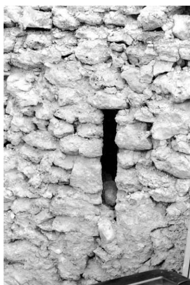
Leesd. Hauptstr. 66, Feuermauer / Lichtschlitz in der Feuermauer (Foto R. Maurer)
