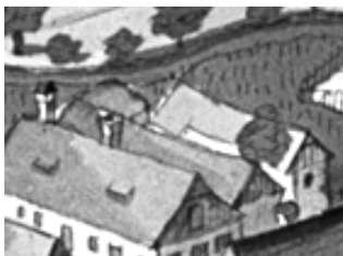
Leesdorfer Hauptstraße 75 (Das große Gebäude links vorne gehört noch zu Nr. 73)
