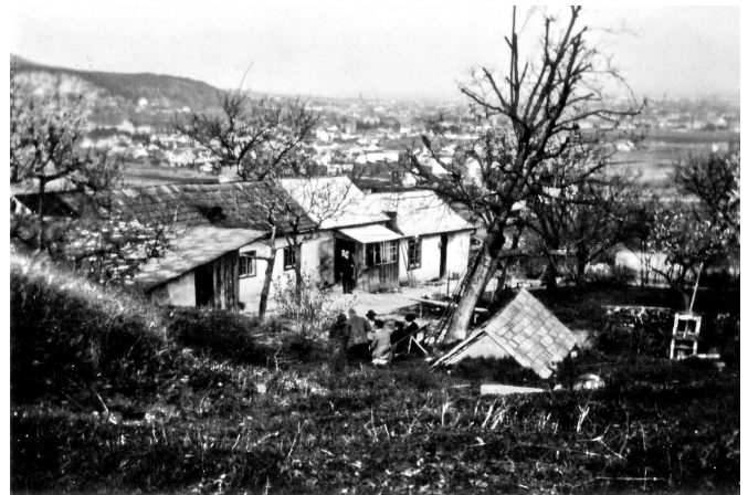
Haus Römerberg 3, Foto 1930er-Jahre (Fotosammlg. Franz Reiter) Links mit Schrägdach die alte Baracke, rechts vorn Erdöpfelkeller!
