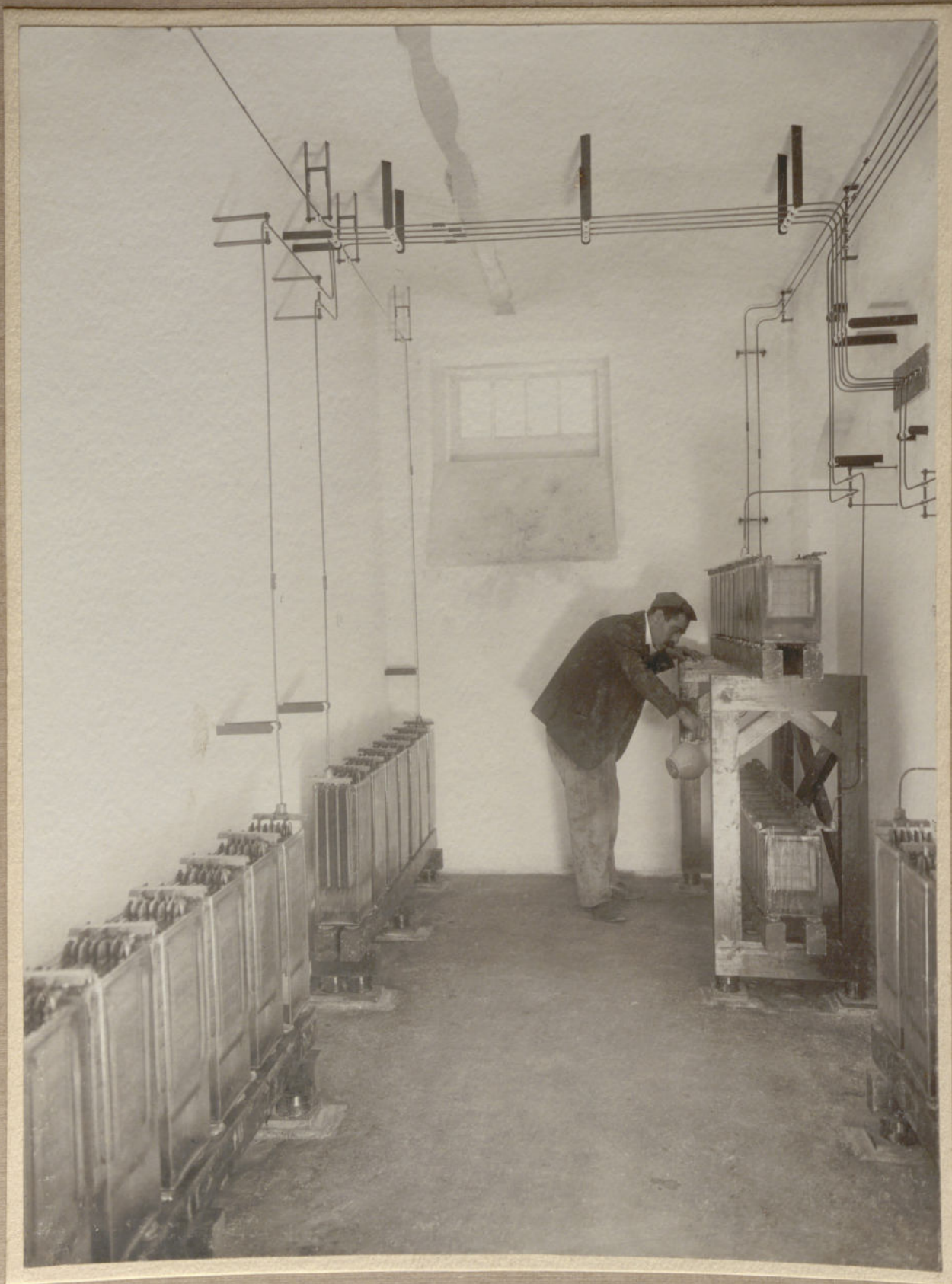
Accumulatorenanlage,
