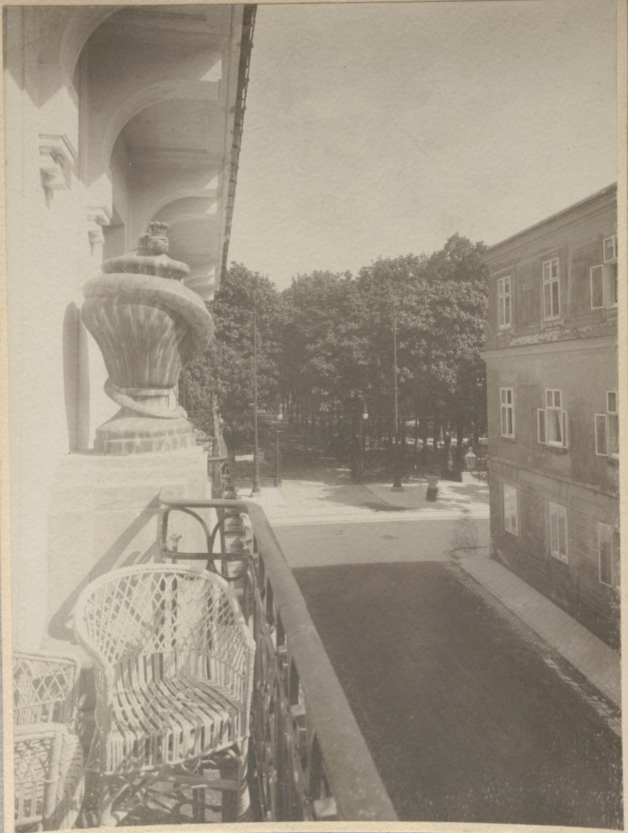
Balkon, oberhalb dem Haupteingang, Blick gegen den Kurpark,
